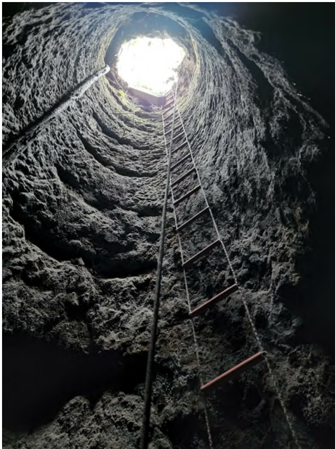
Figura 2. Bocas de salida verticales, tipo chimeneas, donde se ven los huecos que se usaban como escalones.
