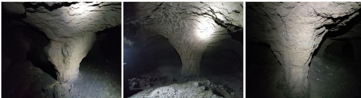
Tuneles de minas de arena en Tandil. Ejemplos de Pilares o Columnas, fotos: L. Garnica
